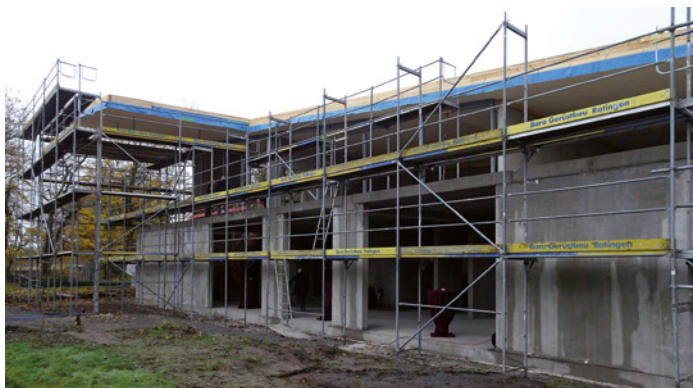
Trotz Einrüstung lassen sich die Dimensionen des Neubaus erahnen.
